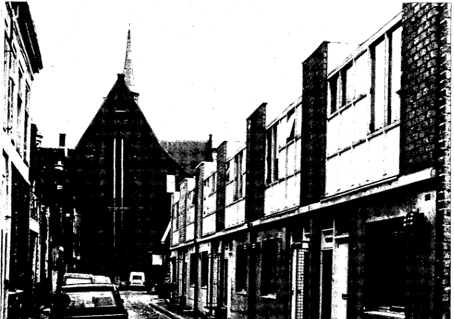
Pietersstraat Haarlem. Westgevel Janskerk en noordgevel van onlangs gereedgekomen woningbouwcomplex van architect Ir. L. C. Röling. Foto: Jos Fielmilch, Haarlem.
