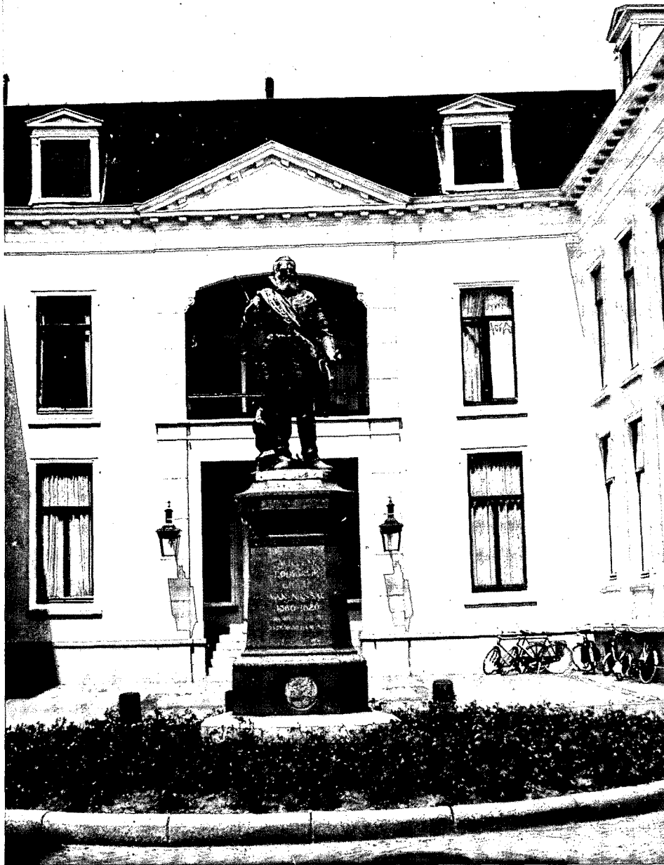
Het standbeeld van Graaf Willem Lodewijk van Nassau (ús heit) voor het thans als stadhuis in gebruik zijnde Stadhoudershof. De laatste verbouwing vond plaats in 1880.
