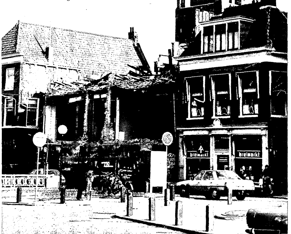
Sloop van het weliswaar door brand ernstig aangetaste, maar daarna zeker nog niet sloopprijpe, Amelandshuis aan de Voorstreek. Op de achtergrond de toren van de Bonifatiuskerk. Foto's Monumentenzorg Leeuwarden.
