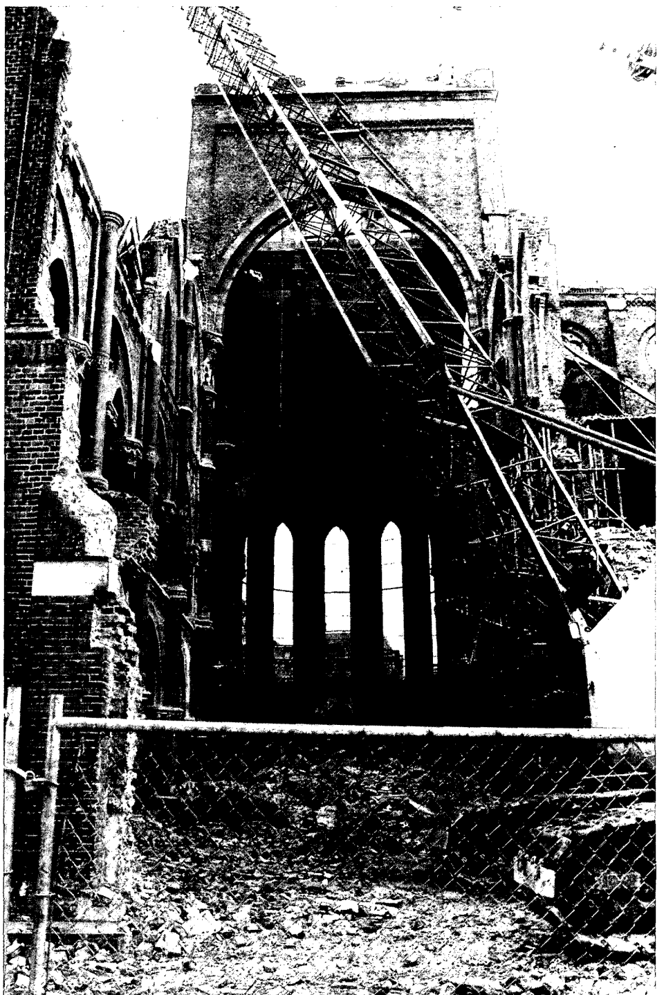
De St. Dominicuskerk te Alkmaar, 2 augustus 1985, vier weken na het begin van de sloop.
