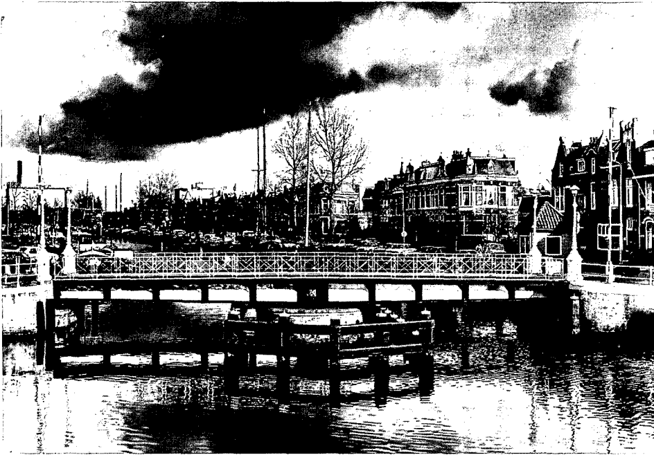
De in 1983/'84 zorgvuldig gerestaureerde Kanaalbrug. De bebouwing langs het Nieuwe Kanaal aan de Emmakade is een fraai voorbeeld van een nog gave wand uit het einde van de 19de eeuw. Foto: Jan Hooghiemstra, Hardegarijp.
