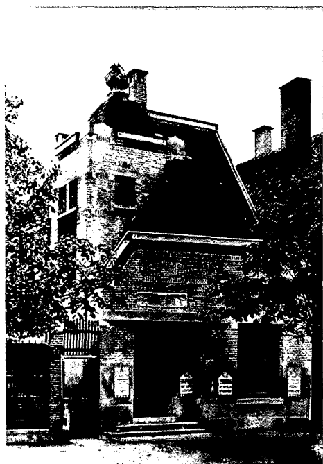
De 'Utrecht' van 1903, gebouwd naar ontwerp van A. J. Kropholler en J. F. Staal. Het pand bestaat uit een laag voorhuis met lichttoren en een hoog achterhuis. Op het dak van de lichttoren de pelikaansculptuur van Jozeph Mendes da Costa. (foto Frans Andringa, Leeuwarden).
