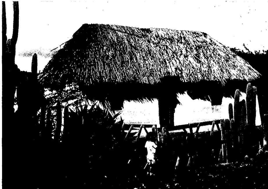
Knoekoehuisje op de weg naar West Punt. Verworven door de Stichting Monumentenzorg en in 1985 gerestaureerd. Het golfplatendak werd vervangen door het traditionele rieten dak. Waarschijnlijk is dit het laatste betrekkelijk gave voorbeeld van een slavenwoning, nu ingericht als 'museum'. (foto A.M. ten Cate, 1986)
