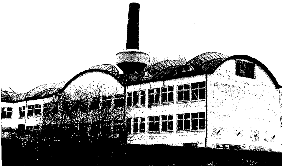
Een gedeelte van de Wiebenga-hallen, dat gesloopt zal worden.
