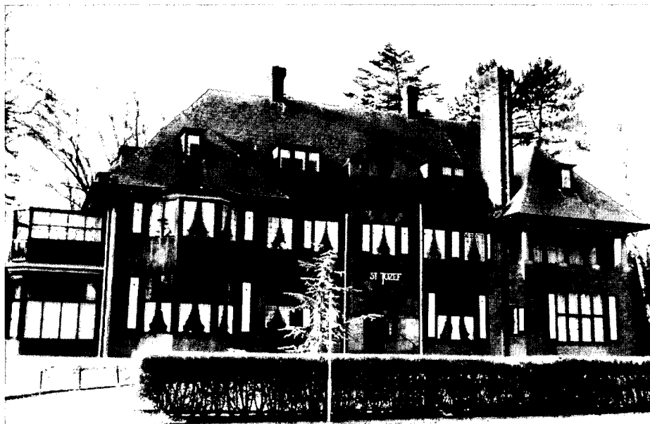
Zusterklooster 'St. Jozef' (1914) aan de Rozendaalselaan, Velp-Noord. De villa heette oorspronkelijk 'Arva'. De architecten zijn Freem en Bremer.
