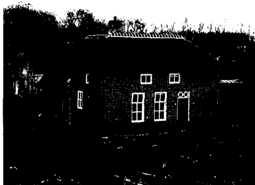
Vervangende nieuwbouw voor het gesloopte rijksmonument te Neerijnen.
