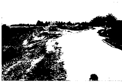
Bocht in de weg bij Maurik wordt recht getrokken in het kader van de dijkverhoging.
