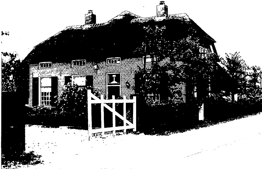
Pas gerestaureerd dijkhuis bij Loo (gem. Duiven), met sloop bedreigd.
