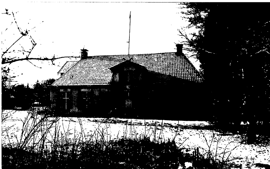
Oostgevel van het westelijke schathuis dat in het begin van de 19e eeuw verbouwd werd tot landhuis. (Fotodienst Provincie Drenthe)
