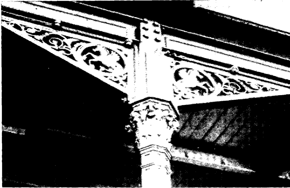
Detail van de perronluifel van het station van Boxtel. Foto KNOB-werkgroep Spoorwegmonumenten.
