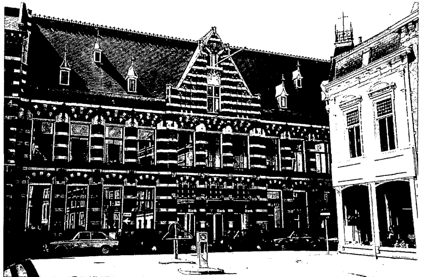
Het vroegere postkantoor van Haarlem, gebouwd naar een ontwerp van rijksbouwmeester Peters. Nu is er een bank in het gebouw aan de Zijlstraat gevestigd. (foto W. Burgers)
