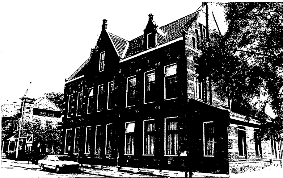
Het voormalig postkantoor in Coevorden uit 1892 aan kasteel 4 (foto Provincie Drenthe)
