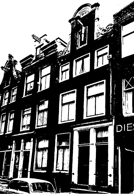
Twee foto's van de Lange Leidsedwardsstraat te Amsterdam vóór en na de restauratie. Bij de restauratie van nr 146 werd besloten de tweeling nrs 144-146 te herstellen door de latere top en gevelindeling terug te brengen in overeenstemming met buurman nr 144. Verantwoord herstel om tot een aaneengesloten gave gevelwand te komen. Zie pag. 13 (foto's Gem. bureau Monumentenzorg, Amsterdam)
