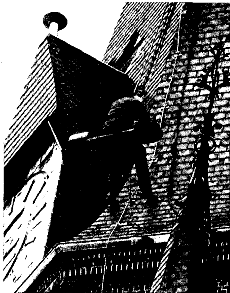
De hoogst noodzakelijke restauratie van het dak van de 'Josef'.
