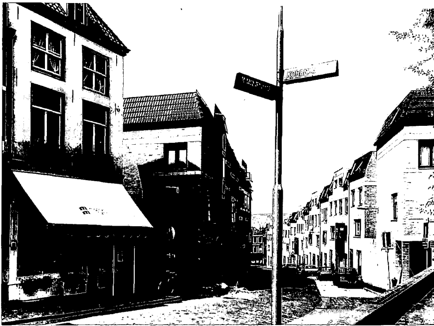
Nijmegen, Kannenmarkt. Herstel van de historische woonfunctie schept een nieuwe identiteit. (foto RDMZ).
