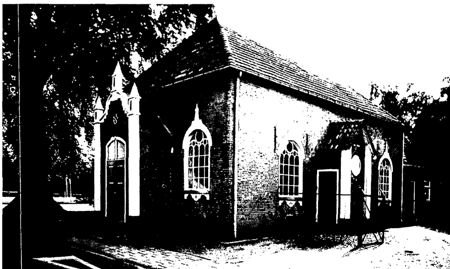
Gereformeerde kerk aan de Enkweg te Voorst. Oorspronkelijk gebouwd als koetshuis bij het aanpandige herenhuis. In 1896 ingrijpend verbouwd tot kerk. Voorbeeld van A-monument.
