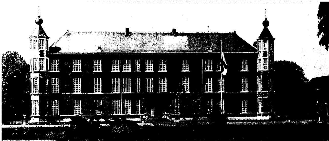
Het 'Kasteel van Breda', zoals het te zien is vanuit het stadspark Het Valkenberg. Links en rechts de in 1964 herstelde torens en in het midden de 'Henricus Poort', die toegang verleent tot de binnenplaats. De tweede verdieping is er in 1826-1829 op gezet en daarboven is weer een zadeldak geplaatst (foto Archief KMA)
