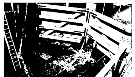
De nieuwe sluisdeuren (vloeddeuren).
