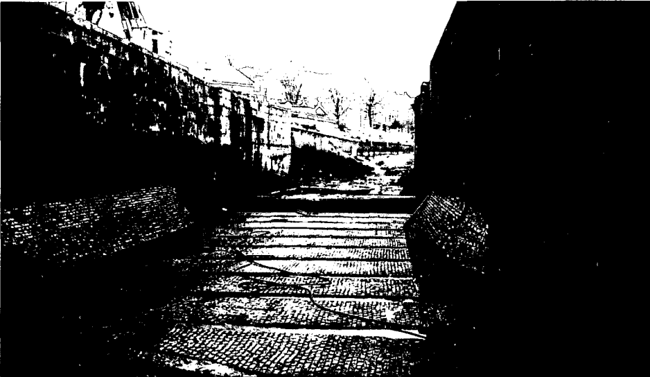
De drooggezette schutsluis. Het 200 jaar oude metselwerk en de evenoude eikehouten balken verkeren in uitstekende staat.
