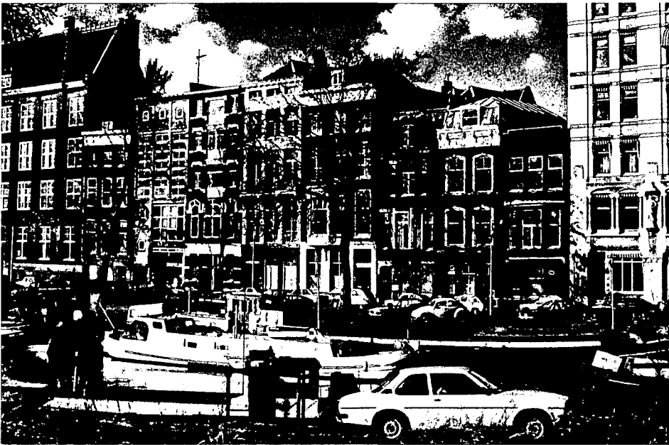
De koopmanshuizen vlak vóór de sloop. Rechts op de foto het Witte Huis.
