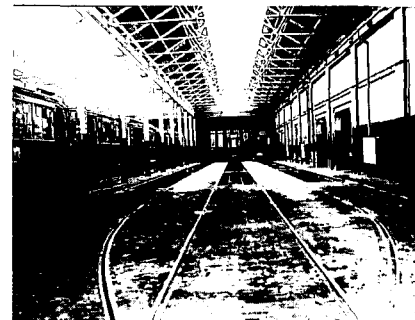
Opname uit 1923 van het interieur van de hallen 2 en 3. (foto Archief GVB).
