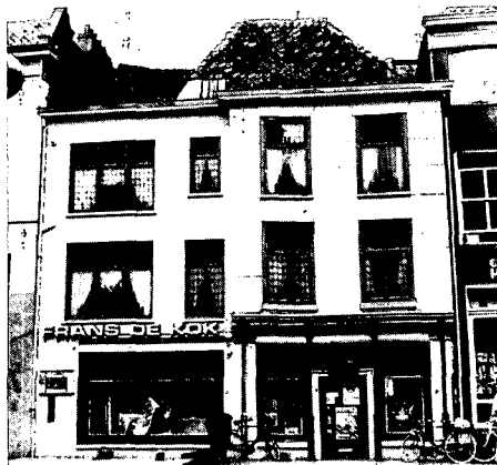
De panden aan de Pensmarkt vóór de restauratie
