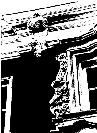
Detail van de middentravee en gootlijst.
