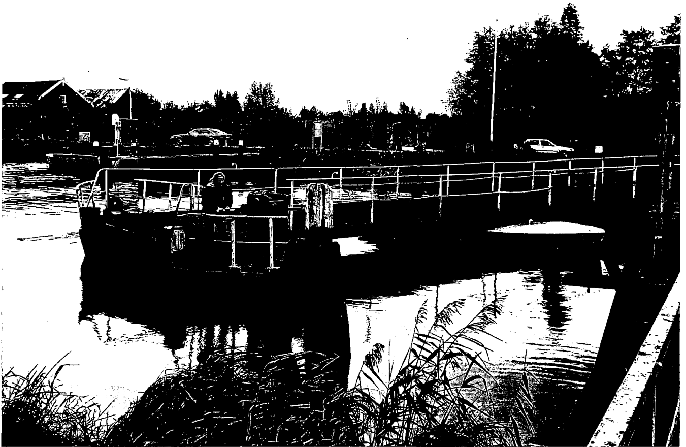
Krane schipbrug over Merwedekanaal bij Meerkerk. Enige nog bestaande schipbrug in Nederland.
