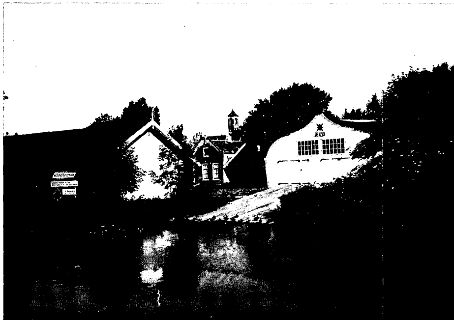
Gezicht op deel van molenerf en houtzagerij na de restauratie (juni 1987). Kijk vanaf Leidseweg aan de zuidoost-zijde.
