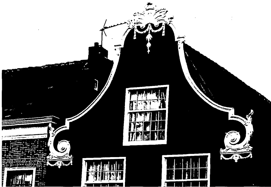
Nieuwe houten gevelbekroning woonhuis De Rijp (NH).
