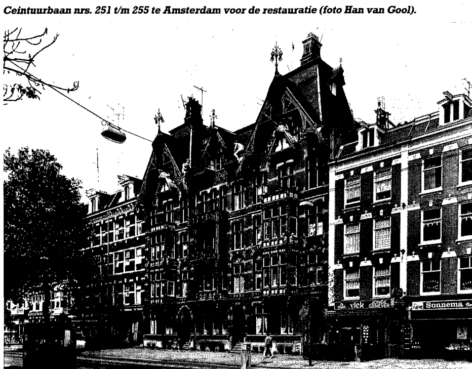
Ceintuurbaan nrs. 251 t/m 255 te Amsterdam voor de restauratie (foto Han van Gool).
