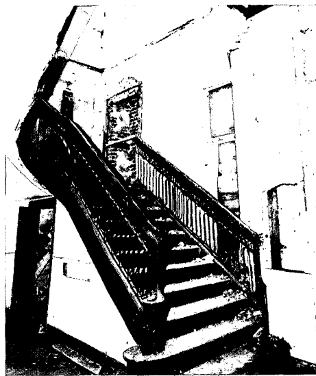
Houten tweeloopstrap met ijzeren balustrade in de hal van het grote herenhuis voor de restauratie (Foto arch. bureau Mertens)
