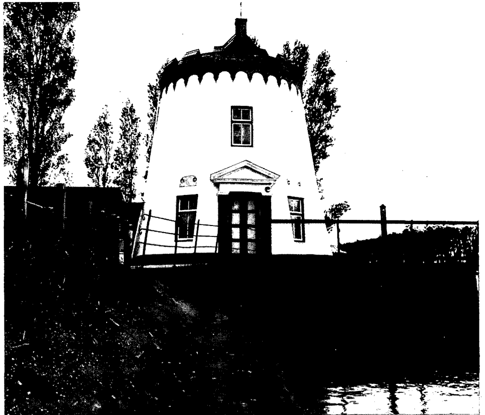
Gemaal van polder Dirksland, Goeree-Overflakkee, Voormalige poldermolen, sinds 1915 in gebruik als dieselgemaal. (Foto Prov. Waterstaat Zuid-Holland)
