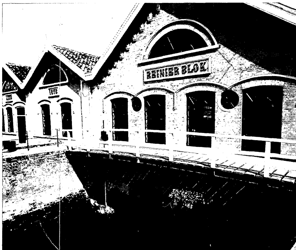
Gemaal 'Reinier Blok', polder 'Den Hoek en Schuwagt', voormalig stoomgemaal (1878), nu uitgerust met twee dieselmotoren (Foto Prov. Waterstaat Zuid-Holland)
