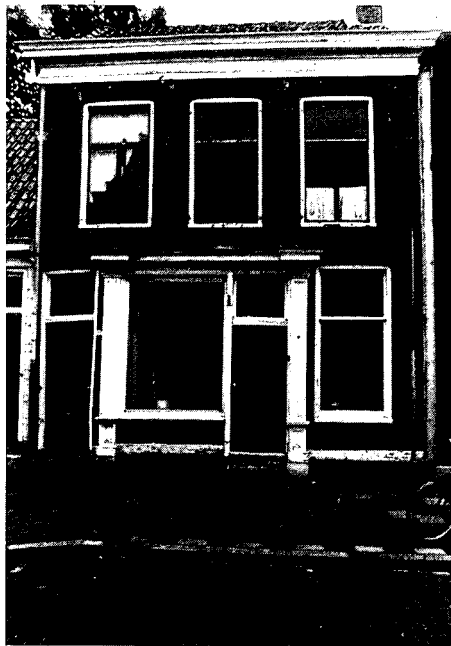
Door de Stichting Stadsherstel Groningen inmiddels gerestaureerd pand Nieuwe Kijk in 't Jatstraat 9 (foto's Stichting Stadsherstel Groningen.)
