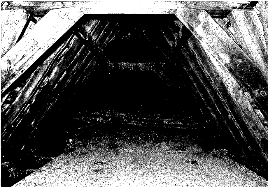
De Grote Middeleeuwse eiken kapconstructie van de hoofdvleugel van het Duitse Huis. De verkrotting heeft hier het hardst toegeslagen. De zolder is bedekt met duivendrek (foto Foto-dienst gemeente Utrecht).
