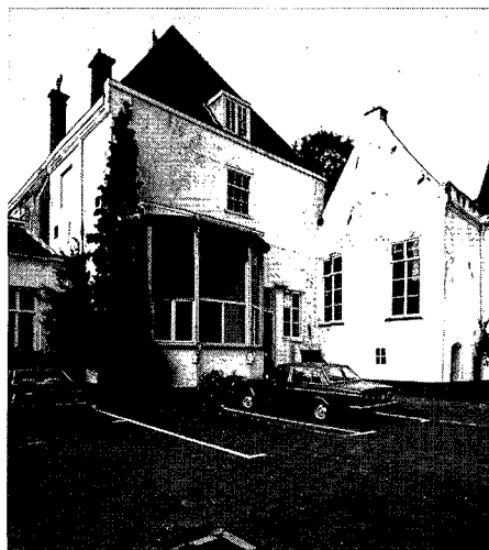
Dit deel van de hoofdvleugel bezat een representatieve trapgevel. Deze werd nog in de 18de eeuw weggebroken. Een grote glazen erker kwam in 1914 voor de prachtige voorgevel te staan omdat de ruimte daarachter dienst moest gaan doen als operatiekamer van het militair hospitaal (foto gem. Utrecht).
