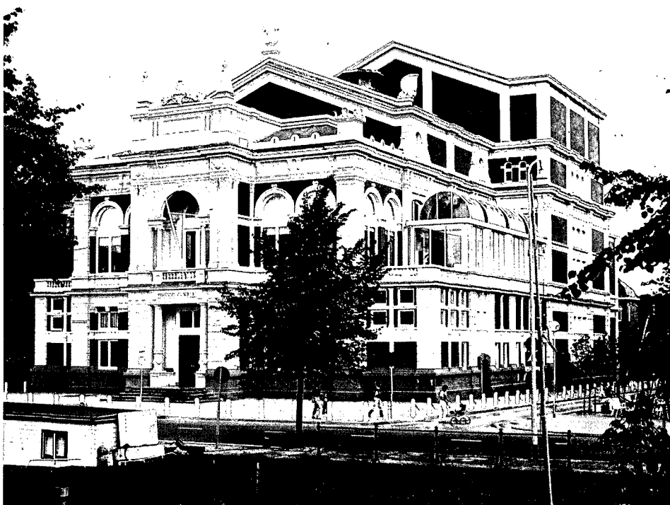
De schouwburg thans, na vergroting en restauratie. De verhoogde toneeltoren is een goed geslaagd voorbeeld van aanpassing aan het ritme en uitmontering van het oorspronkelijke gebouw. De uitgevulde hoekruimten op de begane grond aan de voorzijde zijn gedetailleerd in eclectische stijl; de galerijen op de eerste verdieping kregen daarentegen een hedendaagse vormgeving. Foto: Frank Straatemeier, Groningen
