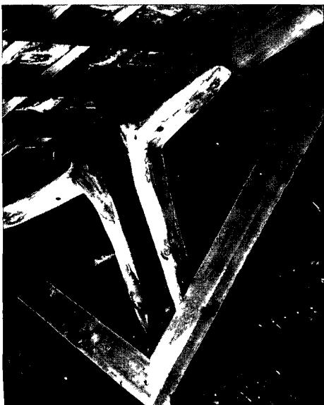
6 Een bijzondere constructie met 'kromhouten' in de kap van een houtloods van de voormalige houtzaagmolen De Bijgeval aan de Leidse Vaart (Foto Gemeentelijke Fotodienst Utrecht)
