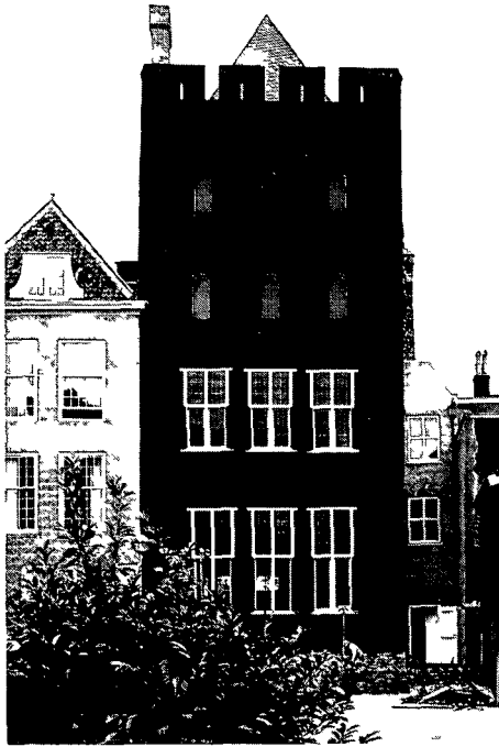
11. De gerestaureerde achtergevel met dezelfde rode kleur die er in 1580 op aangebracht werd. Bij veel andere middeleeuwse huizen in Utrecht treft men deze afwerkingsvorm aan. Links staat het zijhuis. (Foto: Gemeentelijke Fotodienst Utrecht.)
