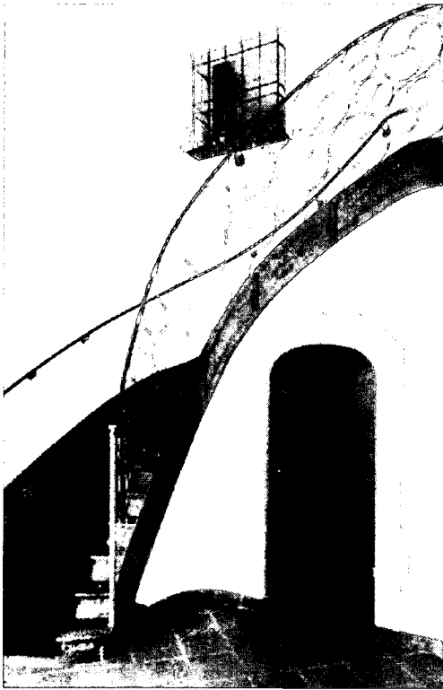
Trap met hekwerk in woonhuis aan Wilhelminapark te Breda. Architect: prof. F.A. Eschauzier
