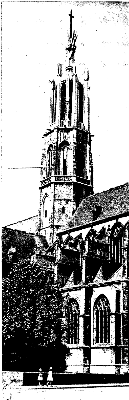
De toren van Hulst met nieuwe betonnen spits
