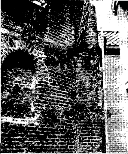
1 en 2 DE VERWOESTENDE WERKING VAN EEN OVERIGENS FRAAIE BERKEBOOM IS DUIDELIJK ZICHTBAAR
