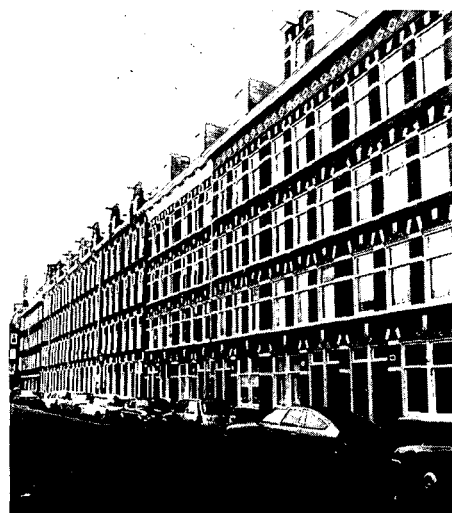
5. Woningblok Gillis van Ledenberchstraat, 1897/98, architect S. P. Herfst voor de Bouwmaatschappij ter verkrijging van Eigen Woningen.
