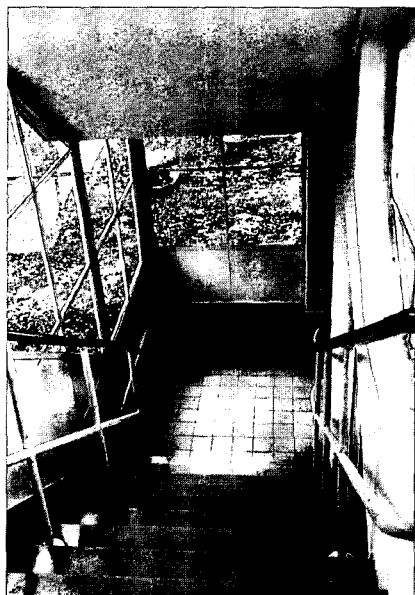
Modern trappenhuis stationsgebouw.
