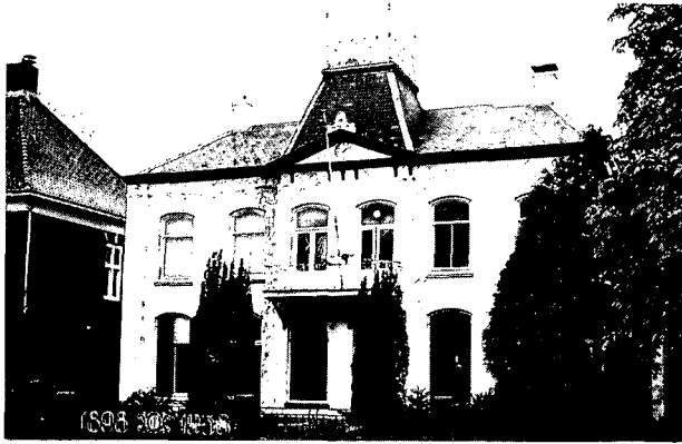
Villa 'Ons Belang' zal worden gerestaureerd. De gemeente draagt bij in de kosten.
