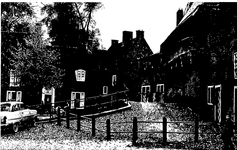
Mooi voorbeeld van nieuwbouw in de jaren '50 die goed aansluit op de historische omgeving.
