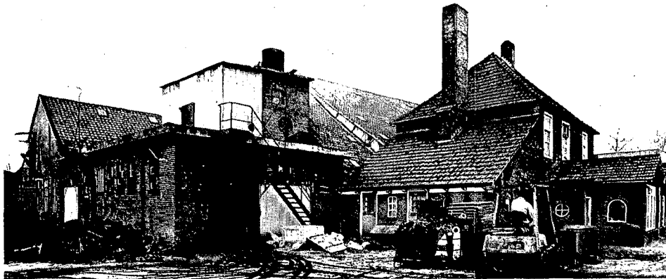
Deel van het gebouwencomplex van de Keppelsche IJzergieterij. Foto: Henk Westerveld, Aalten.
