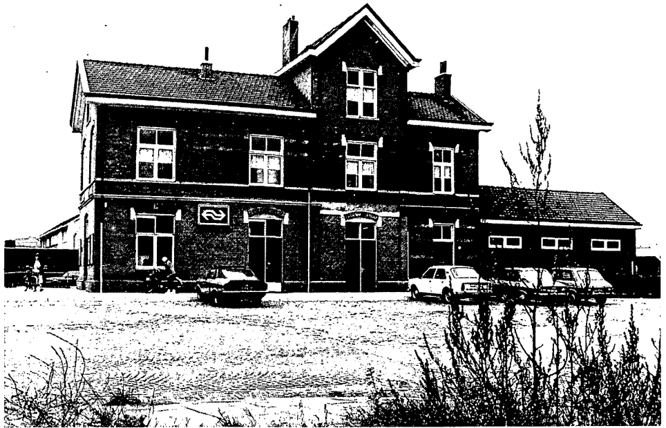
Het in oude staat teruggebrachte station van Aalten.
