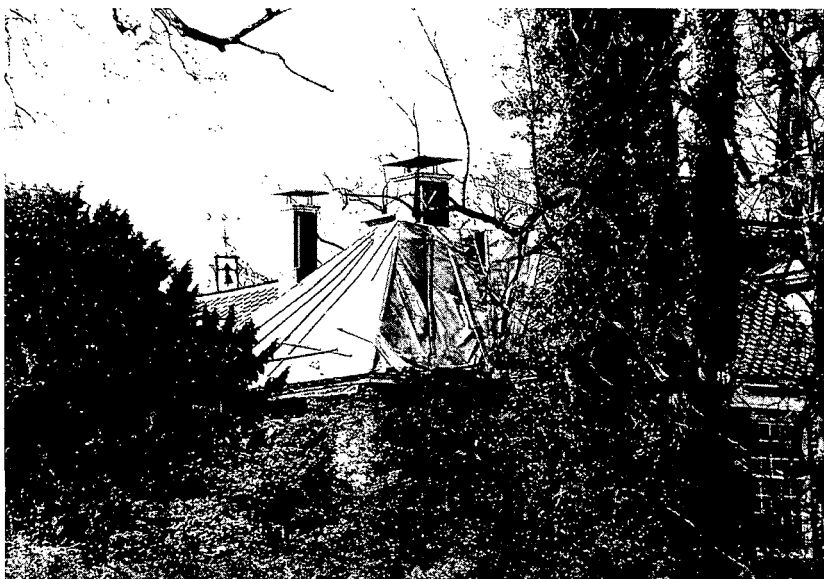
Een detail. Over een gedeelte van het dak is een groot blauw zeil getimmerd, na een schoorsteenbrand in 1985
