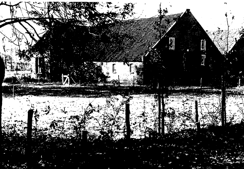
Deel van de voorzijde van de opstallen, gelegen aan de daar lopende parallelweg van de Bennekomseweg.
