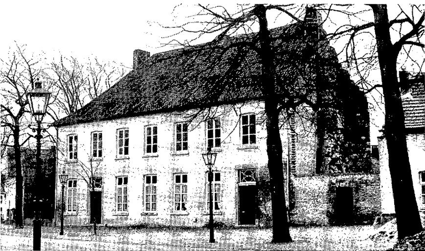
Het 'gouvernement' aan het plein met het restant van de toren
