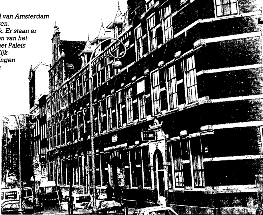
Het voormalige gebouw van het bevolkingsregister (1897-1905), dat zou moeten worden gesloopt. (foto F. Olij, Amsterdam)
