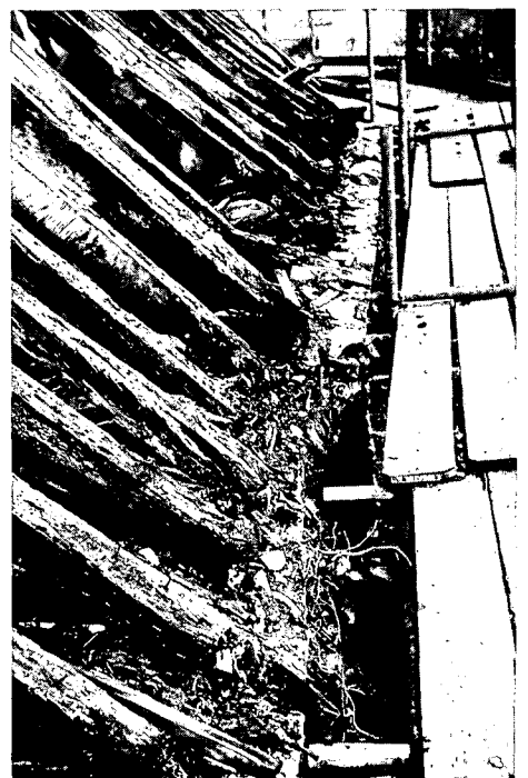
Nalatig onderhoud heeft een verwoestend effect op de kapvoet en het 'steunend' metselwerk (foto van Bruggen).
