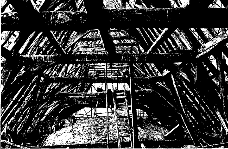
Een oude kapconstructie, ontdaan van het dakbeschot. Resultaat van tijdig onderhoud. (foto Rijksdienst voor de Monumentenzorg, Zeist)
