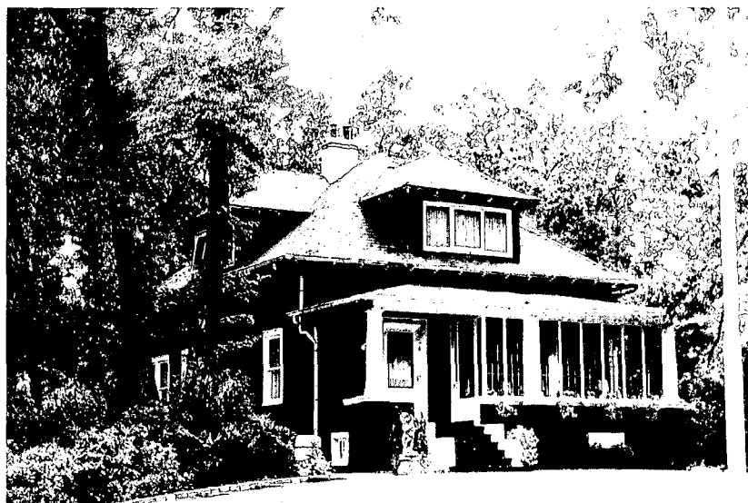
Landhuis 'Bennett Home' (1920), Bennebroek. Gevel aan de Rijksstraatweg (foto's Wim de Wagt, 1990)
