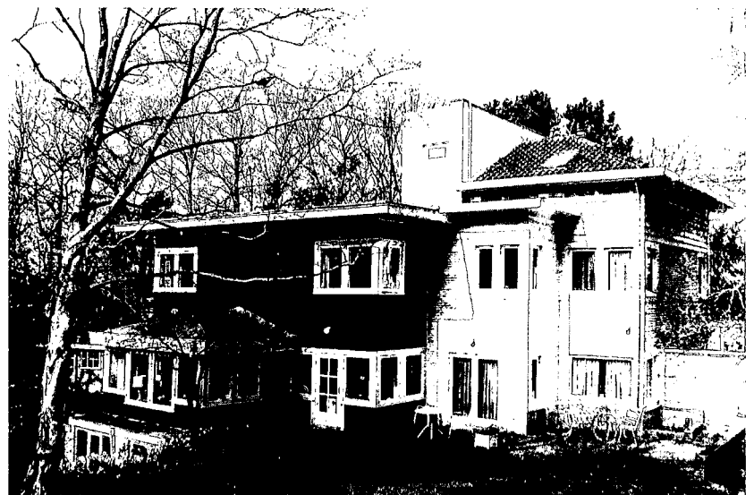
Landhuis Sparrenduin met links het houten huis uit 1922 en rechts de uitbreiding van architect J.C. Brand uit 1929.
