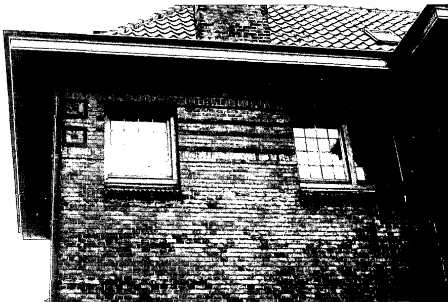
Klattepark; villa hoek Klatteweg/Duinroosweg, detail zijde Duinroosweg.
